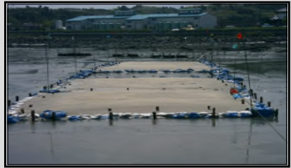
干潟域における囲繞堤・底質改善（比較試験フィールド）
