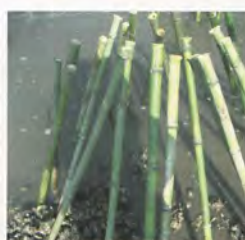
ひび竹設置の様子
